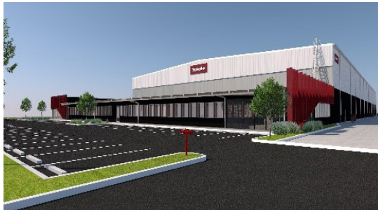
BAC Miele Warehouse (Australia)
