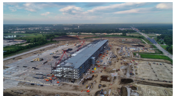
USA - Project Dixie (USA)
